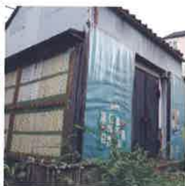
昭和2年竣工の文庫蔵。昭和40年ごろに、補強と湿気対策のため、壁を覆う形で波板トタンが貼られた。
