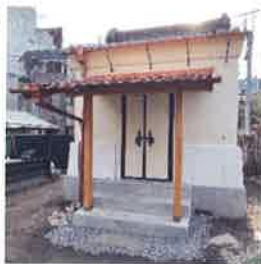
令和4年改修の文庫蔵。柱・土壁・漆喰・瓦など、大幅な修復が施された。
