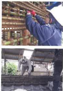
上：壁面の小舞掻き 下：屋根瓦付け
