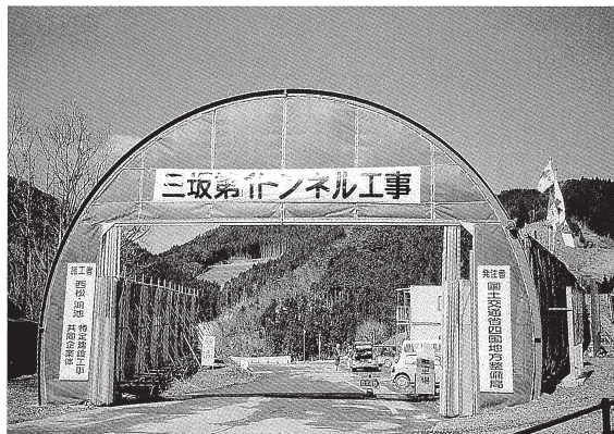
三坂第1トンネル工事
